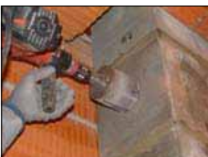
1. Nachträgliche Bohrung im Schacht herstellen
