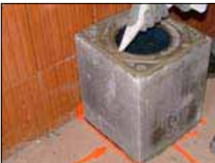
4. Dünnbettmörtel auftragen
