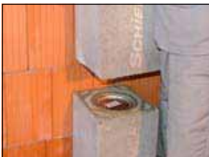
2. Schacht bis zur endgültigen Höhe aufmauern
