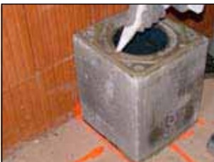
3. Dünnbettmörtel auftragen
