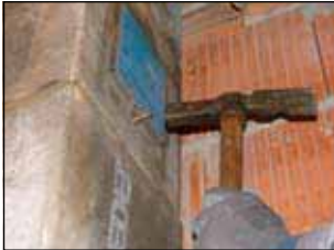
6. Halterung für Abluftelement befestigen
