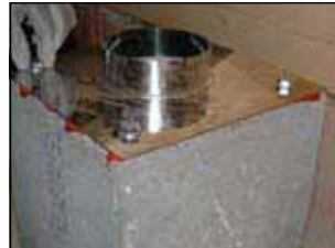
Auf letzten Lüftungsstein Grundplatte Q in Rotempo versetzen und befestigen. Weiterführung der Abluftleitung mit Rohr \varnothing 100 mm möglich.
