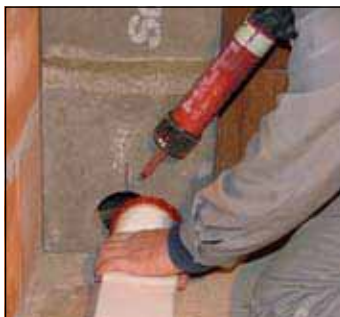
7 Dichtpaste auf Formstück satt auftragen (zB. Rotempo).
