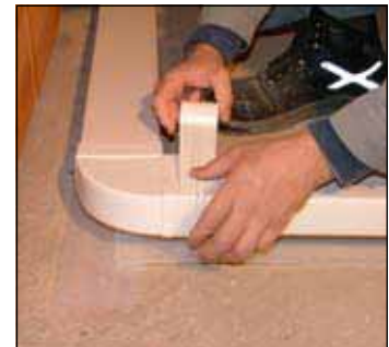
6 Stoßstellen mit Klebeband dicht verbinden.
