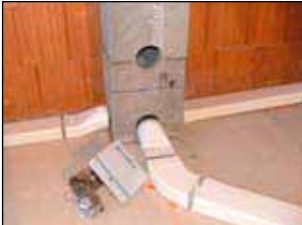
5. Flachkanäle anschließen, optional darüber die Bohrung für Revision herstellen
