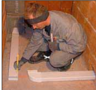
2 Flachkanäle provisorisch auflegen.
