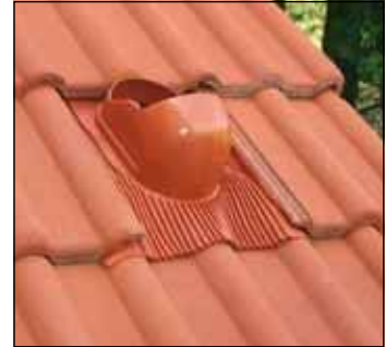
3 Universaldach- Durchgang in Dachdeckung einbauen.
