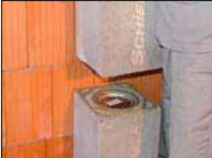
5. Letzten Stein in Dünnbettmörtel versetzen
