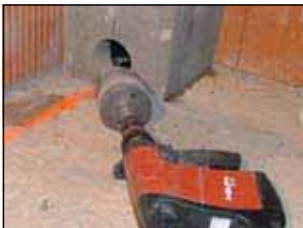
4. Nachträgliche Bohrungen im Schacht herstellen
