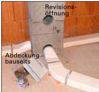
1 Flachkanäle mit Installationen abstimmen.
