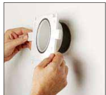
9 Bei Einbau Zuluftset den Ventilhalter andübeln.
