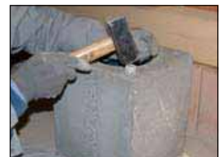
1. Dübel einsetzen
