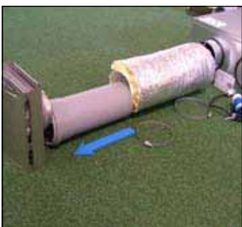
7 Kürzesten und strömungsgünstigen Fortluftweg Ø 125 mm wählen, bei längerem Fortluftweg - Rohr Ø 150 mm.
