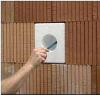
1 Mit Sägeblatt Rohbauver- schluss durchtrennen.
