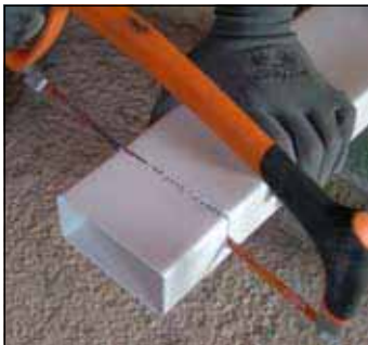
4 Flachkanal ablängen.
