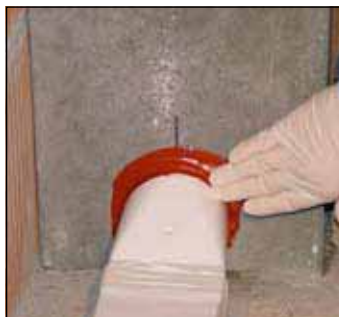
8 Anschlussübergang dicht verstreichen (luftdicht).
