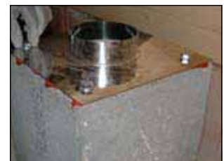
4. Endplatte befestigen
