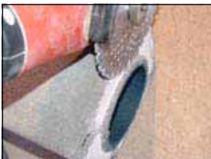
1. Feder vom 1 Stein entfernen
