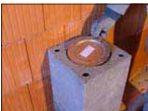
1. Verschlussdeckel auflegen und dicht versetzen
