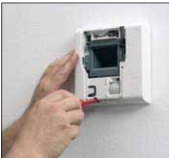
4 Abluftelement einsetzen und anschrauben.
