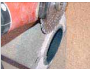
2. Feder vom ersten Stein entfernen
