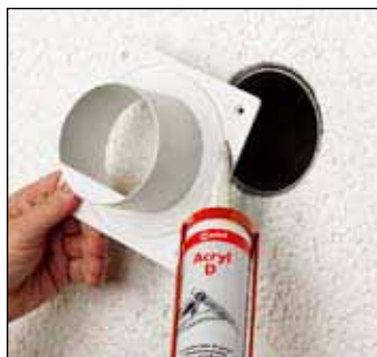
5 Dauerelastische Masse in Dichtrille auftragen.
