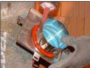
3. Rotempo auf Halterung des Abluftelementes auftragen
