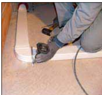
10 Lochband gegen seitliches Verschieben montieren.
