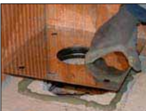
1. Grundplatte Q in Dünnbettmörtel versetzen. Deckenöffnung mind. 15/15 cm
