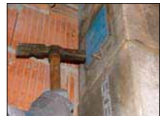
2. Halterung für Abluftelement befestigen
