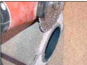
1. Feder vom ersten Stein entfernen
