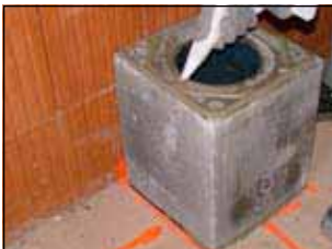
4. Dünnbettmörtel auftragen
