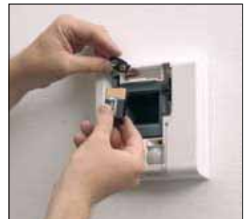
6 Bei Stoßlüftungselementen: 9V Alkaline Batterie einsetzen (nicht im Lieferumfang).
