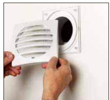
3 Abdeckung mit Insekten- gitter aufklicken.
