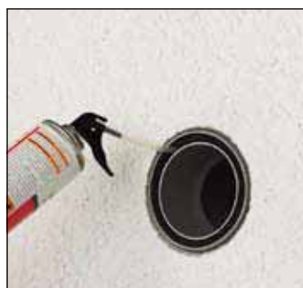
2 Spalt ausschäumen zum Schutzrohr oder zur Wandbohrung.
