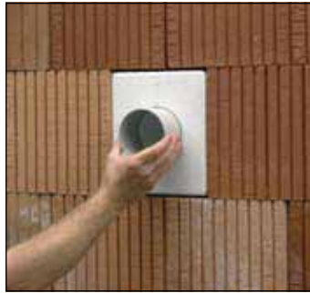
2 Ausgleichsrohr auf entspre- chende Fassadenstärke ablän- gen und einbauen.
