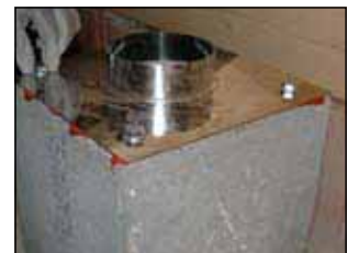
5. Endplatte befestigen
