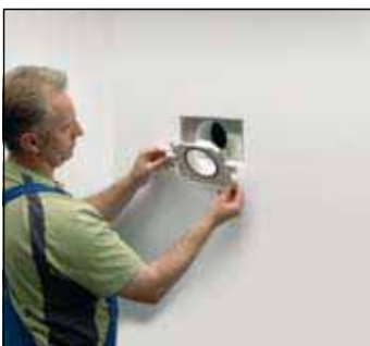
7 Abdeckfolie entfernen, Ventilhalter einbauen.
