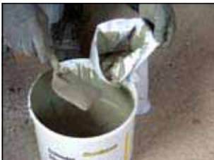
2. Dünnbettmörtel mischen und anfüllen
