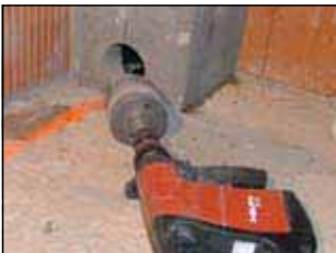
4. Nachträgliche Bohrung im Schacht herstellen
