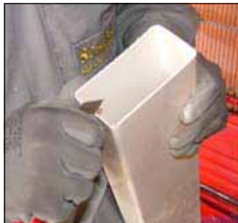
5 Schnittkanten entgraten Flachkanal innen säubern.
