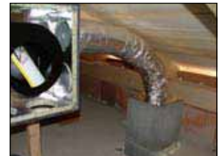
5. Flexschlauch befestigen
