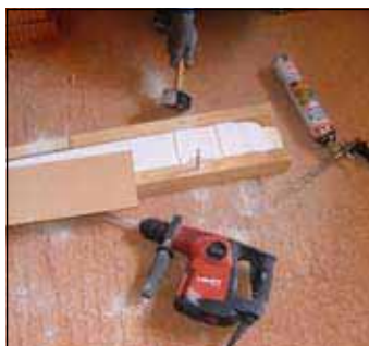
11 Umlenkungen und Deckendurchgang einschäumen.
