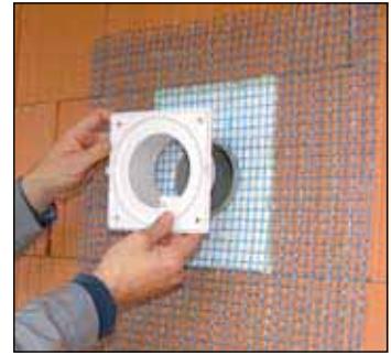
3 Bereich Einbaublock „netzen“ Öffnung vor Verputz schützen.
