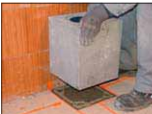
3. ersten Stein auf Grundplatte V versetzen
