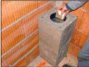
6. ausquellenden Mörtel verstreichen
