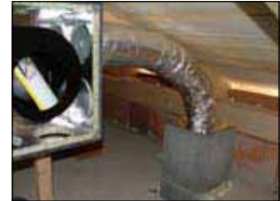
6. Flexschlauch befestigen
