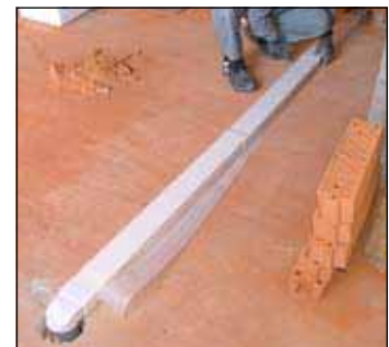
9 Dämmstreifen unterlegen.
