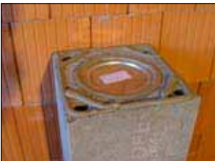
4. Zwischen letzten und vorletzten Stein Verschlussdeckel einsetzen
