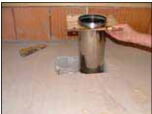
1. Endplatte mit Deckendurchführung einsetzen und Dünnbettmörtel auftragen
