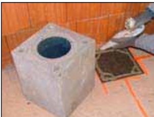
2. Erster Stein auf Grundplatte V versetzen
