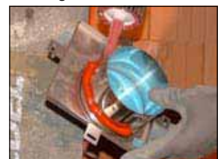
1. Rotempe auf Halterung des Abluftelementes auftragen
