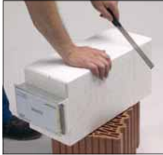
2 Einbaublock auf Wanddicke kürzen max. um 12 cm kürzbar.
