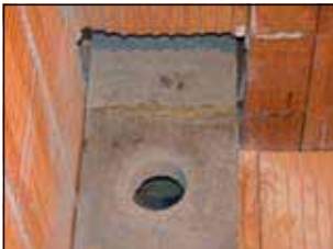
3. Nachträgliche Bohrungen im Schacht herstellen
