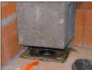
3. Ersten Stein auf Grundplatte V versetzen
