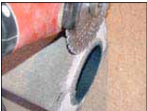
2. Feder vom 1. Stein entfernen und in Dünnbettmörtel versetzen
