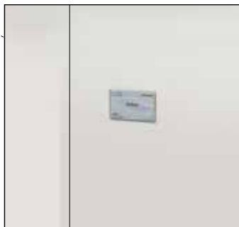
5 Fertig eingebauter Einbaublock in der verputzten Wand.
