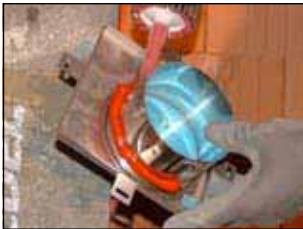
5. Rotempro auf Halterung des Abluftelementes auftragen
