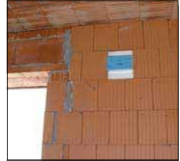
3 Einbaublock in vorletzter Zie- gelschar mitmauern.
