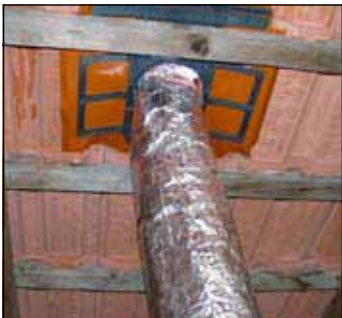
4 Flexschlauch mit Vendoctrrohr hochschieben, oben einrasten
