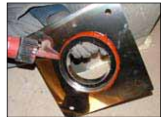
4. Rotempe auf Endplatte auftragen
