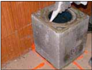
3. Dünnbettmörtel auftragen
