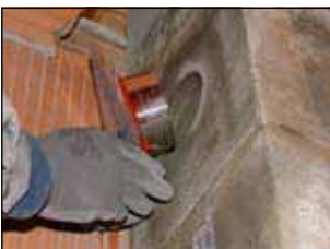
2. Halterung für Abluftelement einsetzen
