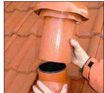
6 Kondensatabweiser mit Wetterschutzhaube aufschrauben.
