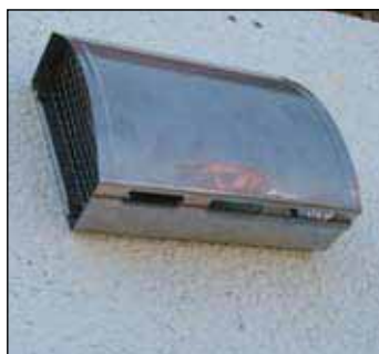
8 NIRO Wandstutzen Ø 125 mm Fortluftausblasung ins Freie, oder in einem Lichtschacht.
