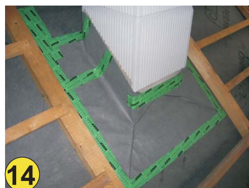
14 Fertigansicht, Dach - und Konterlattung können jetzt wie gewohnt fertiggestellt werden.
