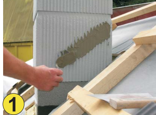
1 Bei Verwendung des Schiedel TOP Systems ist vor Anbringen der Dichtfolien ein „Glattstrich“ mit Dünnbettmörtel auszuführen.
