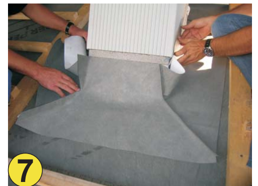
7 Vordere Dichtfolie verlegen und an das BUTYL -BAND fest andrücken.
