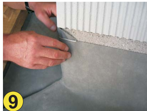
8 Umschlagen und verkleben der Überstände an den Ecken.
