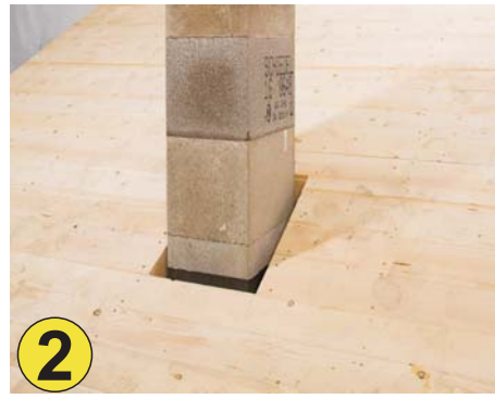
2 Bei Standard-Mantelsteinen kann ohne Vorarbeiten mit der Montage des Folien-Dicht-Sets begonnen werden.
