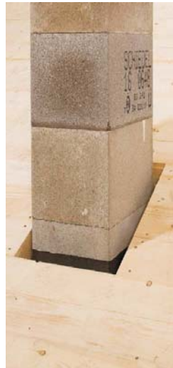
1 Bei Verwendung des Schiedel TOP Systems ist vor Anbringen der Dichtfolien ein „Glattstrich“ mit Dünnbettmörtel auszuführen.
