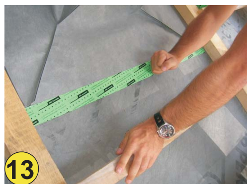
13 Winddichtes Verkleben des Schiedel Foliensets mit der bauseitigen USB - Bahn.
