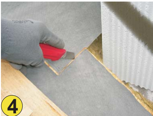
4 Ausschneiden der Unterspannbahn. Unter diese wird der obere Teil des Foliensets- eingeschoben.
