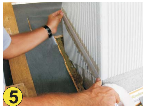
5 BUTYL - Kleband auf dem angetrockneten Glattstrich umlaufend anbringen.
