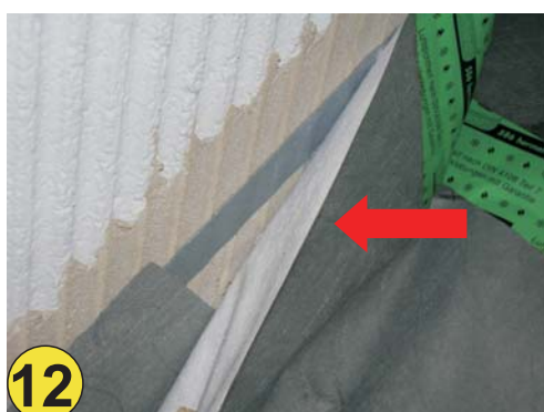
12 Seitliche Folienteile fest an das BUTYL - Band andrücken.
